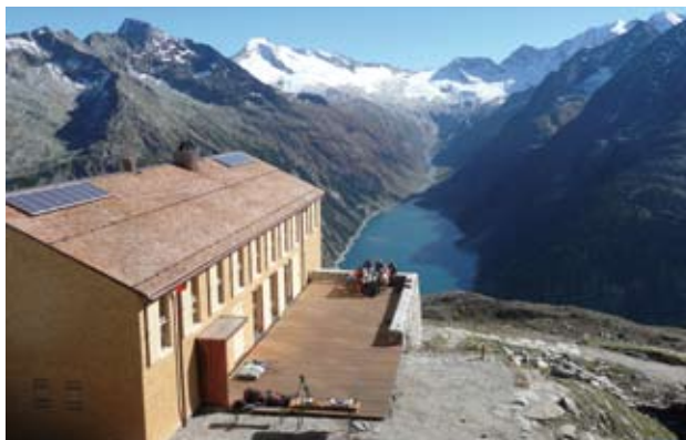
Die 2007 neu errichtete Olperer Hütte mit Blick auf den Schlegeisspeicher.
